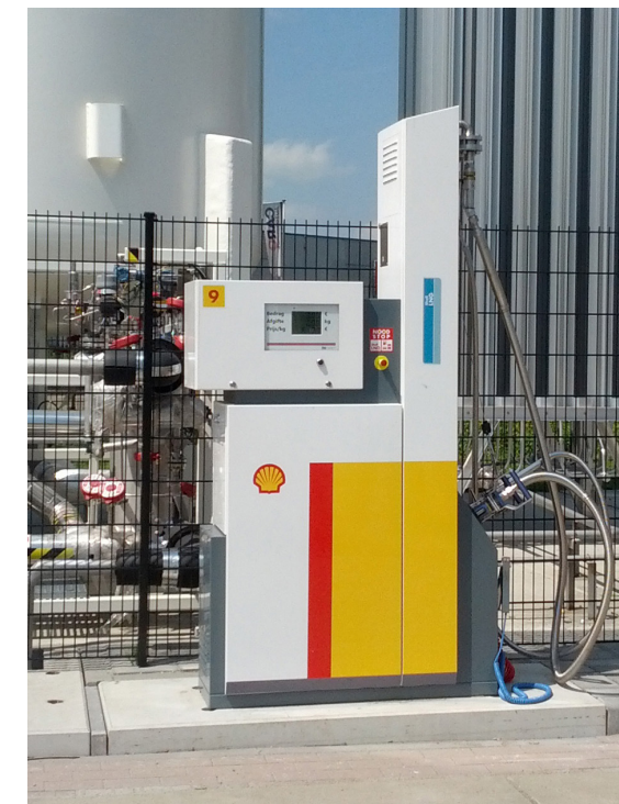
Výdejní stojan pro zkapaněný zemní plyn designovaný pro Chart Ferox. Vlevo skici k tomuto projektu.
